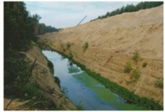
Łagów 06.10.2010. na brzegu pomiędzy Gronowem Poźrzadłem = w budowie autostrady...
